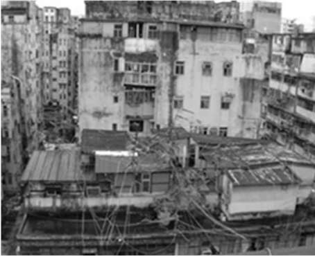
写真 14-2 香港のルーフトップ (屋上小屋)
