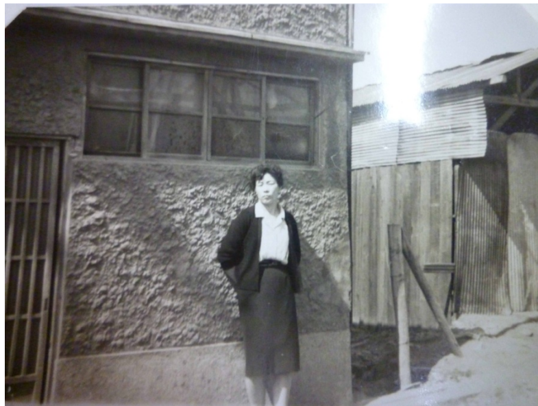
【写真5】1950年代後半の西成区の様子。右後方にバラック小屋が見える。調査対象者提供
