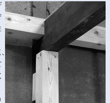
工事中の北終長屋 新旧の柱が入り混じる
