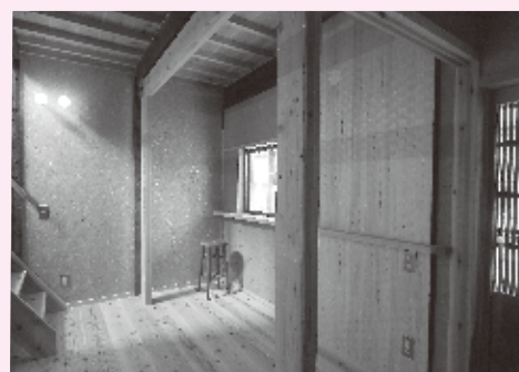
耐震フレームの向こうに窓台を兼ねた手すり
