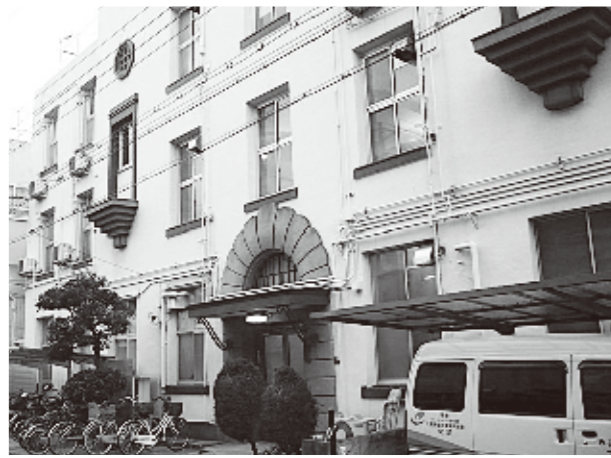
1926年築の建物を利用する大淀寮の外観
