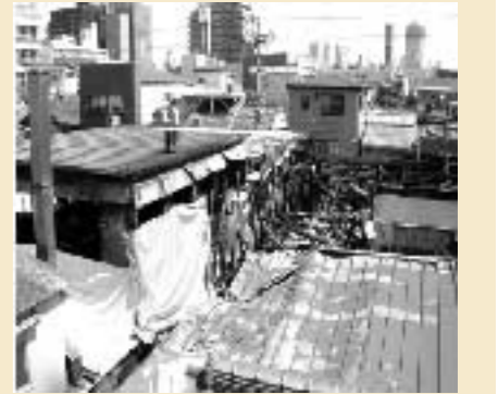
火災延焼の危険性が高い密集市街地
