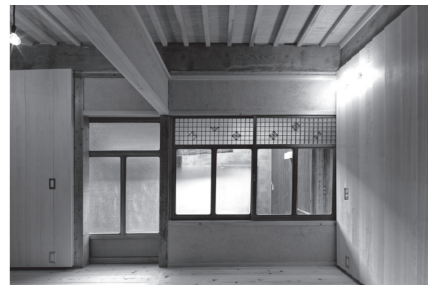
新設のたれ壁(上)と腰壁(下)
