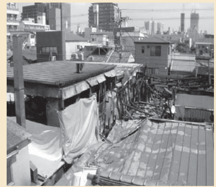
火災延焼の危険性が高い密集市街地
