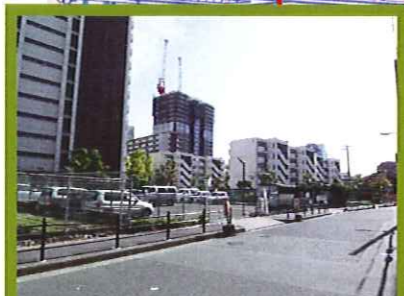
かつてのゴム工場敷地がそのまま団地に変貌しています。奥ではタワーマンションも建設中です。
