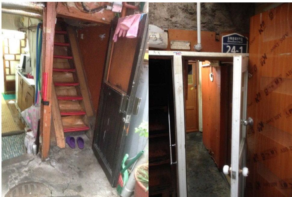
写真Ⅲ-1-3 二階へと向かう狭い階段 写真Ⅲ-1-4 建物の狭い間口
