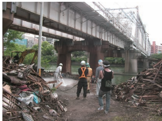
龍王宮撤去作業撮影の様子
