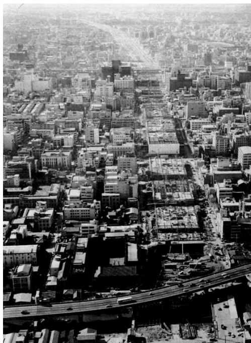
建設段階の築港深江線と船場センタービル(財団法人大阪市土木技術協会, 1995)
