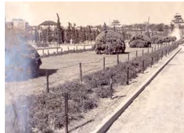
昭和59年(1984) 大阪城植栽工事
