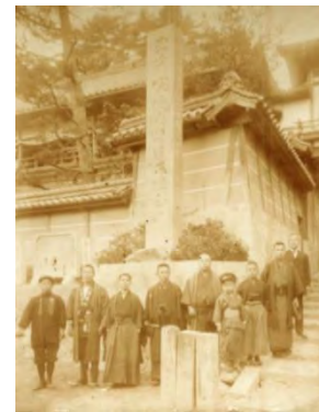
明治43年(1910)信貴山朝護孫子寺 玉蔵院の石垣工事完成時の写真
