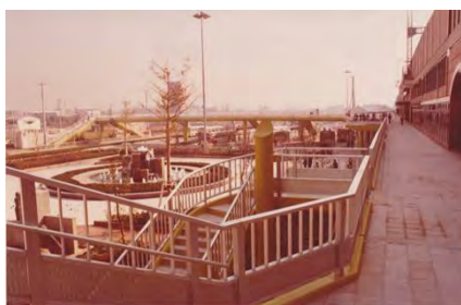
昭和53年(1978)近鉄八尾駅前噴水工事
