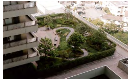
大阪市立総合医療センター屋上植栽工事
