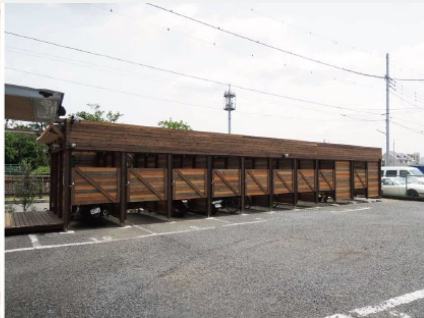
住み手の要望を取り入れ敷地内にバイクガレージを設置
