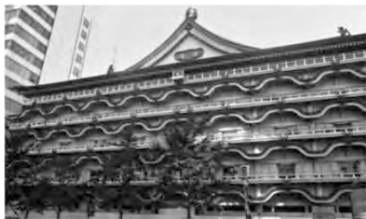
36体の照起屋根を配した大阪新歌舞伎
