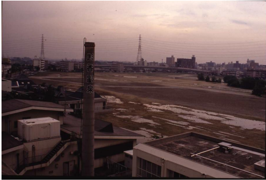
地下鉄車庫の撤去
