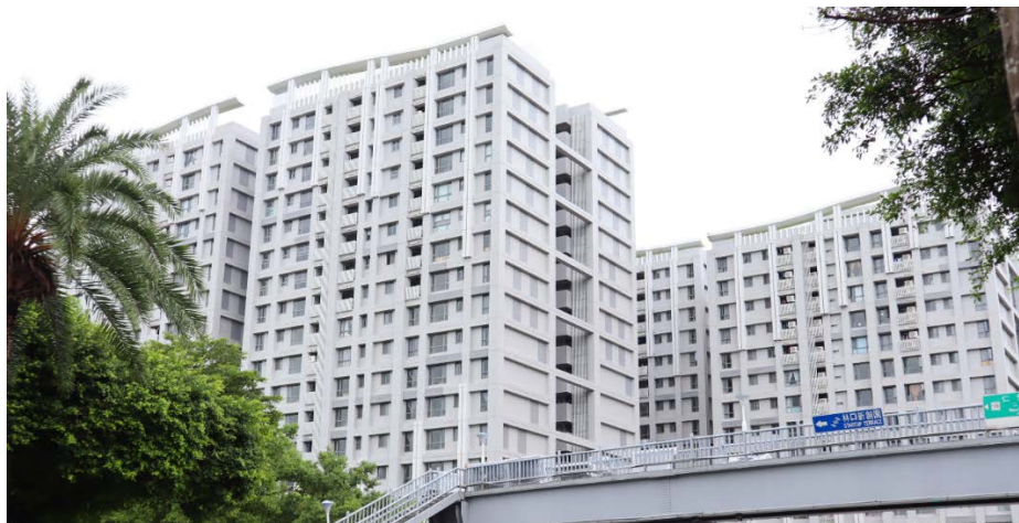
図 7-1 林口世第運選手村社会住宅(林口社宅)の外観
