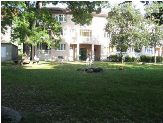
図 15 : ヴェストエントのブロック 21 樽工場跡地に建設された代替住宅ブロック の中庭
