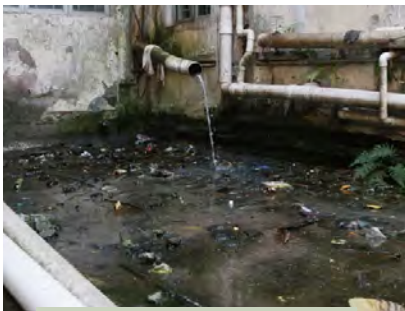
多渠互通 Communal sewage system
