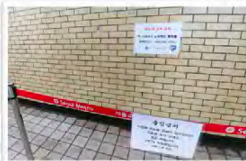
'역사 내 노숙금지', '시설을 보호'를 위해 설치된 침시유지선
